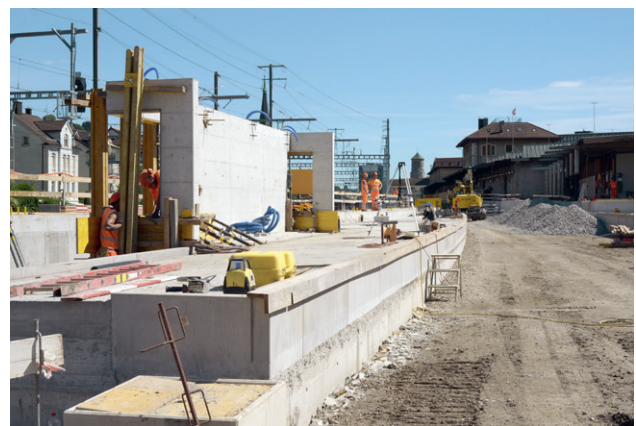
Bau Warteunterstand Güterbahnhof St.Gallen
